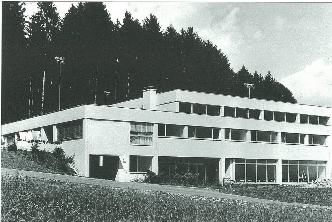
Turnhalle «Rotbach» mit Kindergarten, Sanitätsposten und Haus- wartswohnung.
