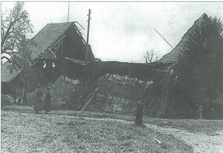
Scheune Gremsen nach dem Unwetter, 1927.
