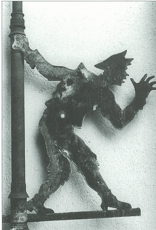
Originelle Wetterfahne auf der Turmspitze, mit sichtbaren Spuren von Blitzeinschlägen. Demontiert und vergoldet anlässlich der Renovation 1991/92.
