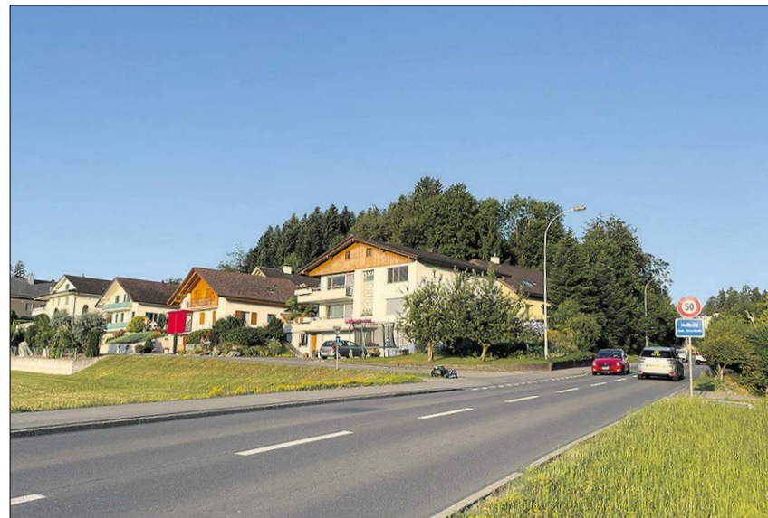
Die Zufahrt zum neuen Schulhaus soll im Gebiet Halde eingangs Hellbühl von der Hauptstrasse wegführen. Foto Stefan Schmid
